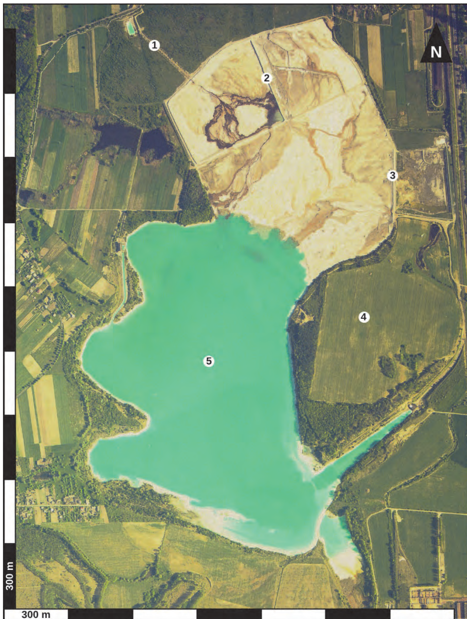
Fot. 54. Konin-Gosławice, zbiornik popiołów (2002): 1 – kolektor doprowadzający, 2 – grodzie w zbiorniku, 3 – groble tamujące, 4 – tereny zrehabilitowane, 5 – zbiornik osadowy; fot. A. Kijowski
